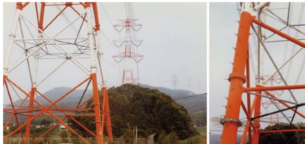
圖8.4 近期的電力供應鋼塔(含金屬管)
