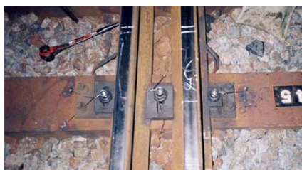
圖8.8 搭配使用應變規來安裝CD紋螺栓
