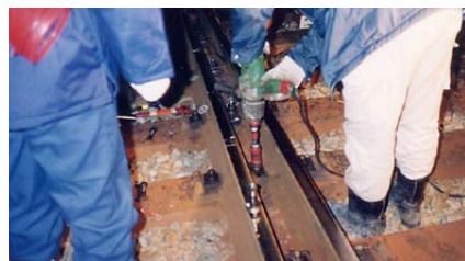
圖8.7 使用衝擊式扳手進行鎖固作業
