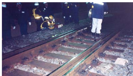
圖8.6 東海道新幹線鐵道的彈性接合點
