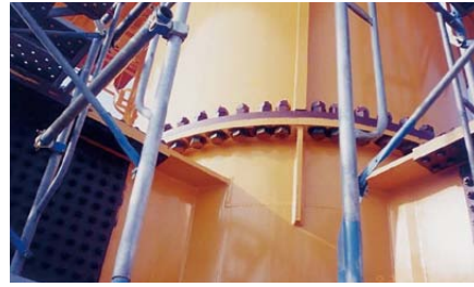
圖8.18 將CD紋螺栓安裝到爬升式起重機的爬升桿
