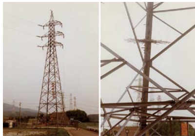
圖8.3 供應電力的傳統等角鋼塔
