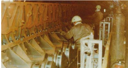
圖8.15 將CD紋螺栓鎖固到燒結機的側壁
