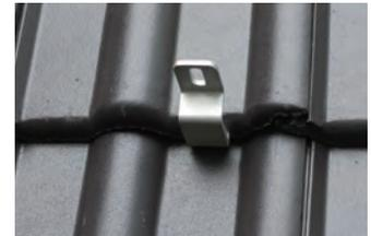
圖五、安裝後的EJOT®太陽能鉤
