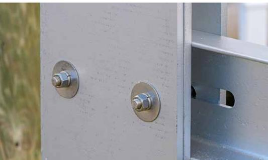
圖 3: 劈開式鎖緊墊圈的應用
