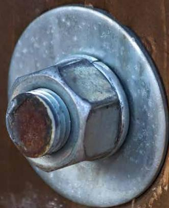
圖 1: 大型平墊圈可在較大的接觸面積上分散載荷
