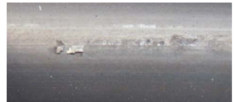
圖1. 鋼材表面剝片缺陷外觀
