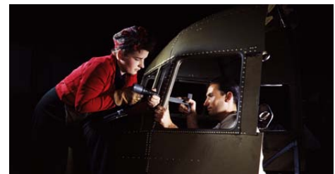
圖3 飛機駕駛艙鉚釘施工情形- 左方女生使用氣動槍，右方男生使用頂鐵
