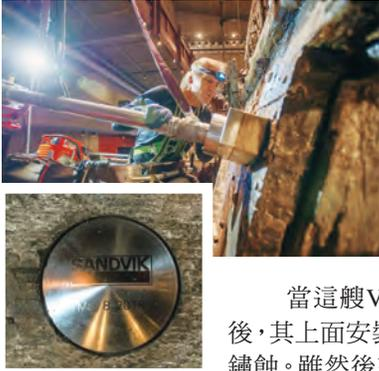
瑞典Sandvik日前已經完成4,000多顆專門打造用以替換原本古代戰船上生鏽螺栓的高合金不鏽鋼螺栓替換作業。這些可以支撐至少150年的螺栓將賦予這艘瑞典國寶戰船一個全新的開始。
